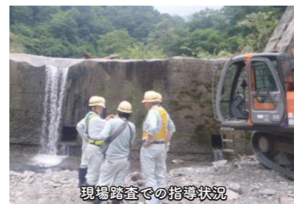
工事現場状況
