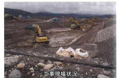
工事現場状況
